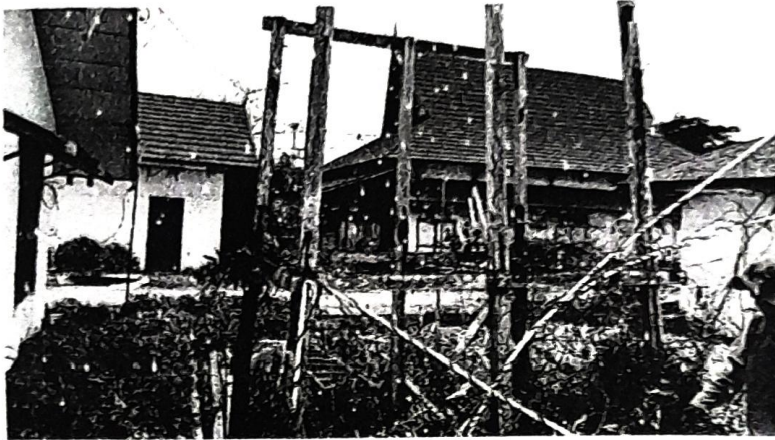
Pembongkaran Tower Air lama
