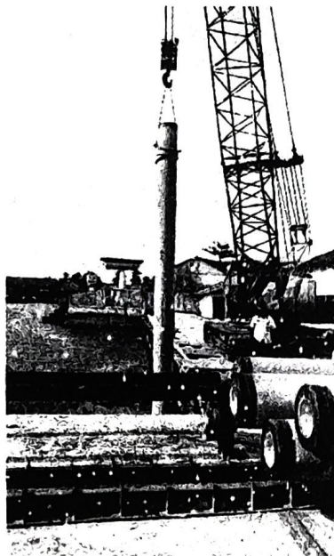
Mobilisasi Peralatan Pemancangan Tiang Pancang di Lokasi Pekerjaan
