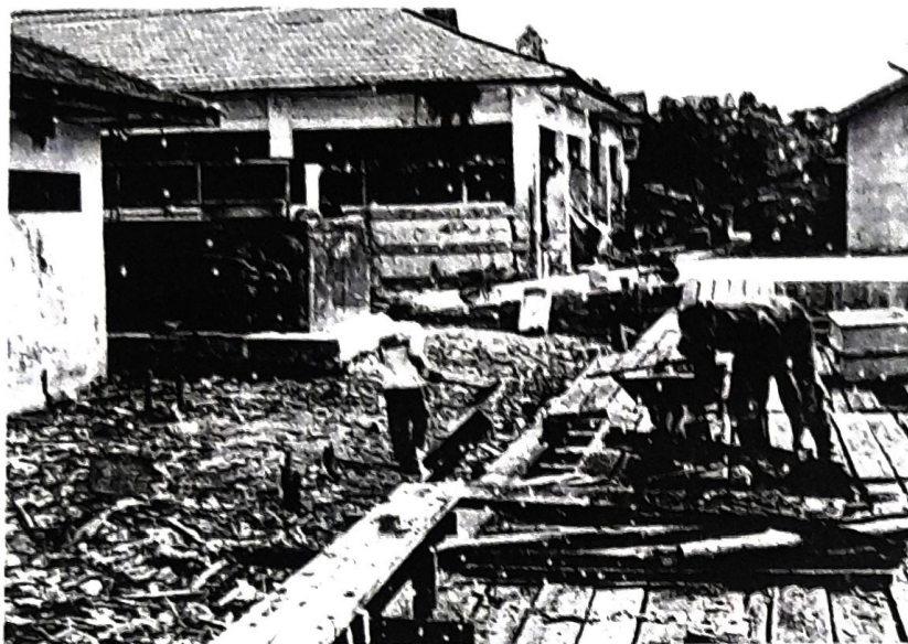
Pembersihan Lokasi dan Pembongkaran Bangunan Lama
