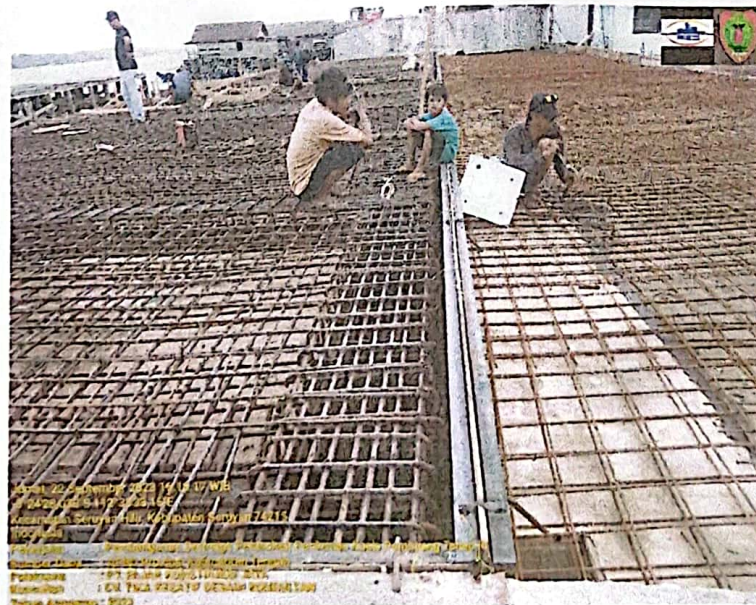
PEKERJAAN LAS PLAT SIKU 5.5 JOINT SAMBUNGAN
