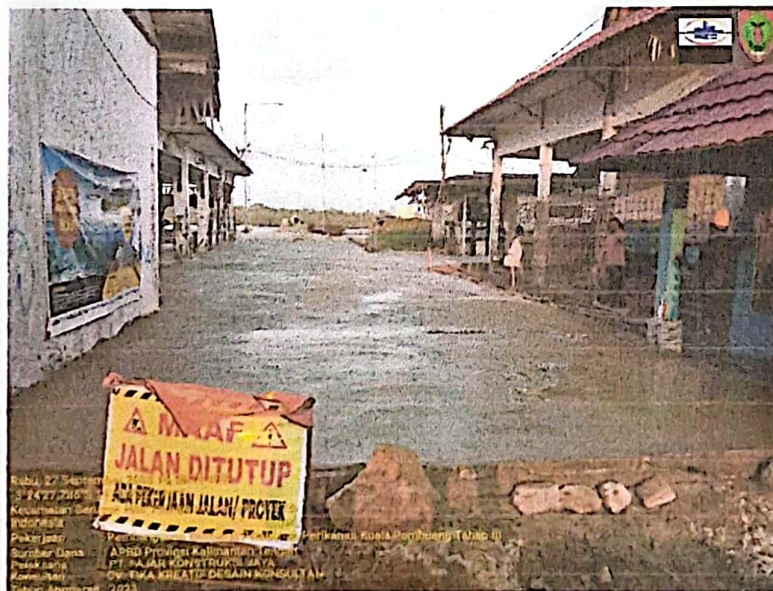
PEKERJAAN PENGECORAN JALAN AKSES MASUK KE DERMAGA
