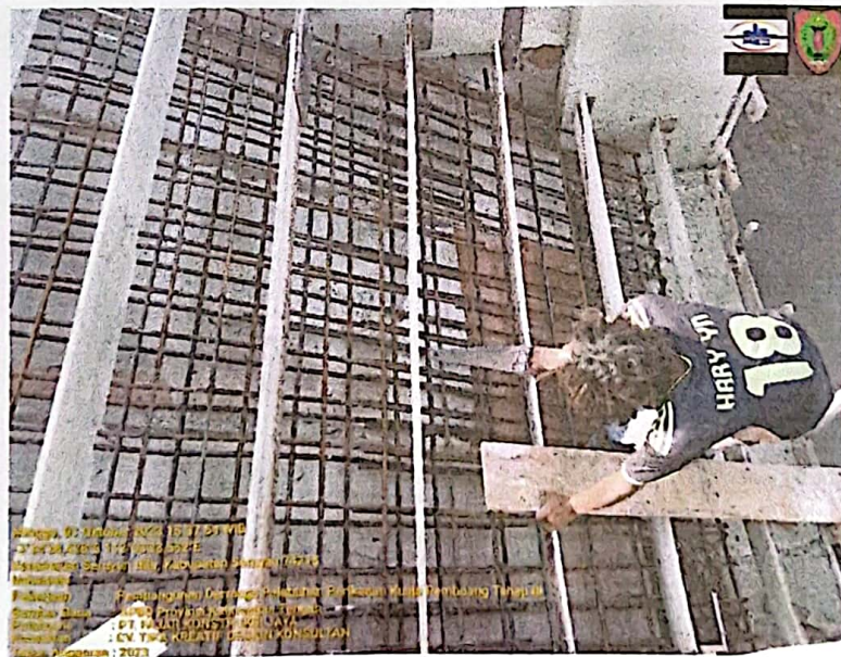
PEKERJAAN PERAKITAN PEMBESIAN TANGGA
