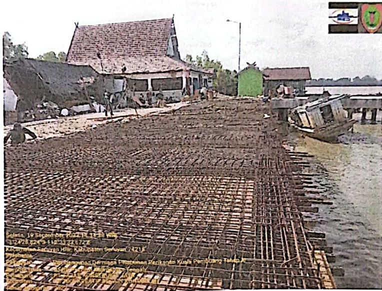
PEKERJAAN PERAKITAN PEMBESIAN LANTAI
