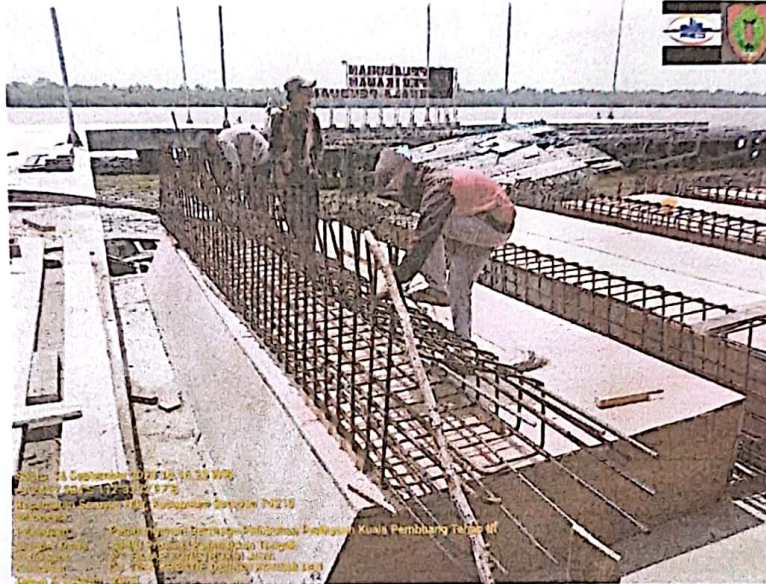
PEKERJAAN PERAKITAN PEMBESIAN BALOK
