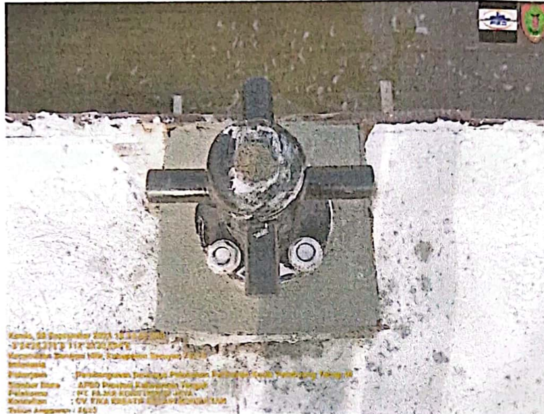
PEKERJAAN PENGECORAN ANGKUR BOLLARD
