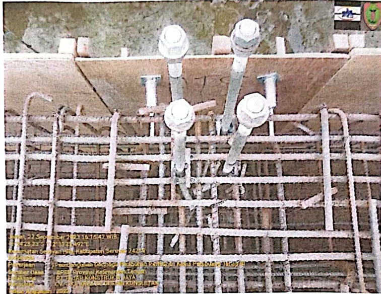
PEMASANGAN ANGKUR BOLLARD
