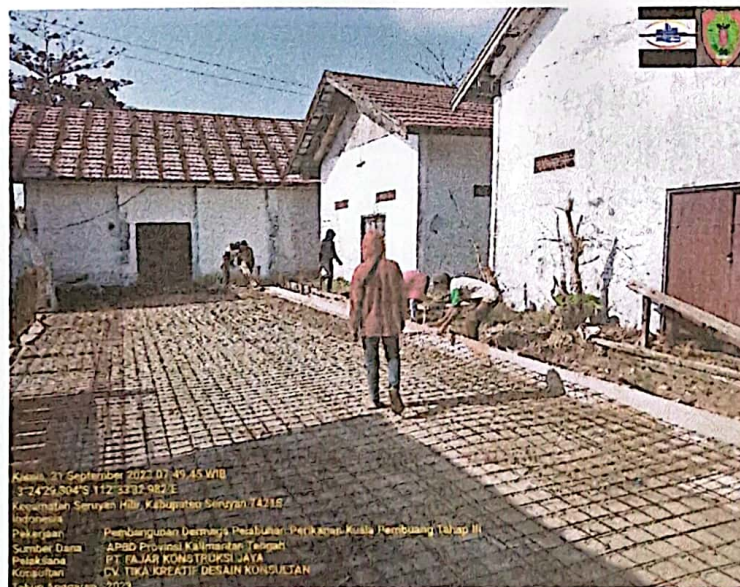
PEKERJAAN PERAKITAN PEMBESIAN JALAN AKSES KE SPBU
