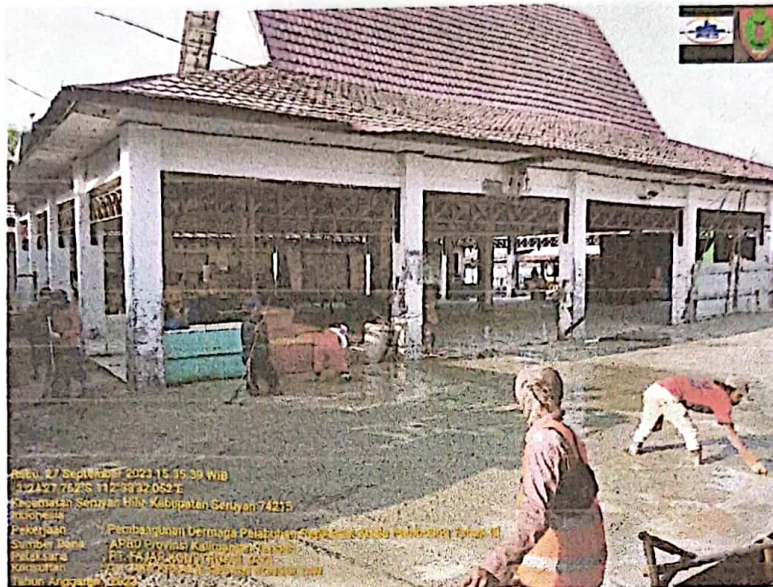
PEKERJAAN PENGECORAN JALAN AKSES MASUK KE DERMAGA
