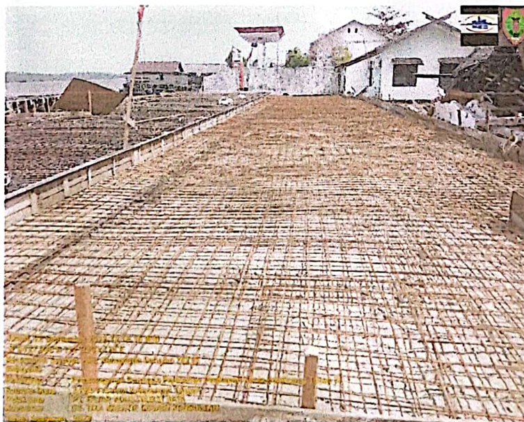
PEKERJAAN PERAKITAN PEMBESIAN SELASAR DERMAGA
