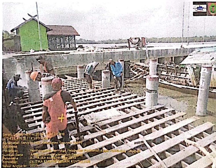
PEKERJAAN PEMOTONGAN TIANG SPON PILE
