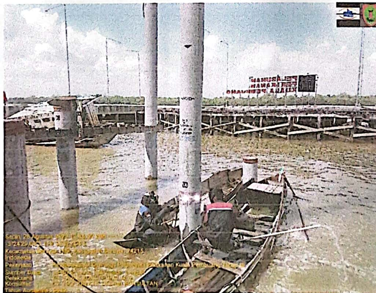
PEKERJAAN PENGELASAN SAMBUNGAN PLAT PADA TIANG
