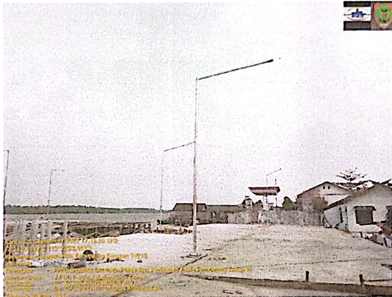
PEKERJAAN PEMASANGAN TIANG PJU
