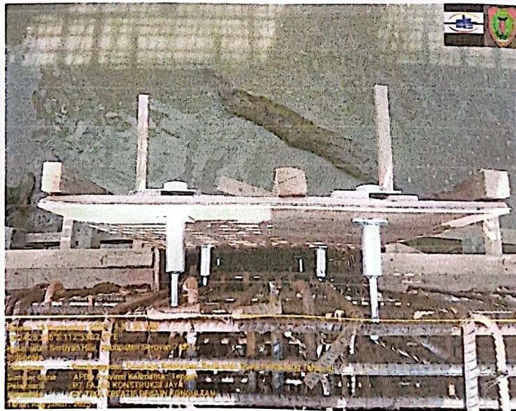
PEMASANGAN ANGKUR FENDER
