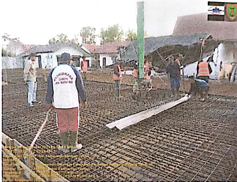
PEKERJAAN PENGECORAN BALOK, BALOK FENDER & LANTAI DERMAGA
