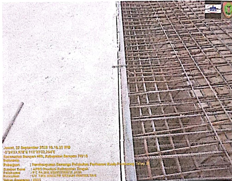
PEKERJAAN PERAKITAN PEMBESIAN JOINT SAMBUNGAN
