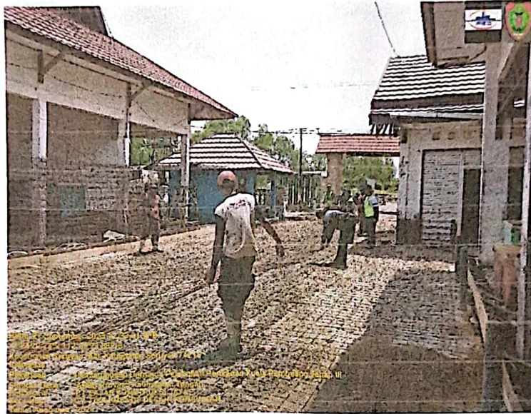
PEKERJAAN PERAKITAN PEMBESIAN JALAN AKSES MASUK KE DERMAGA
