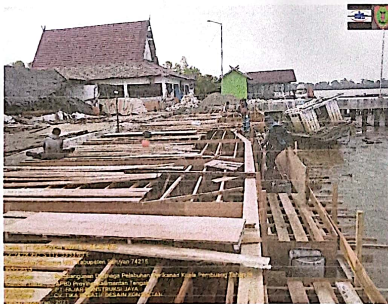
PEKERJAAN BEKISTING LANTAI
