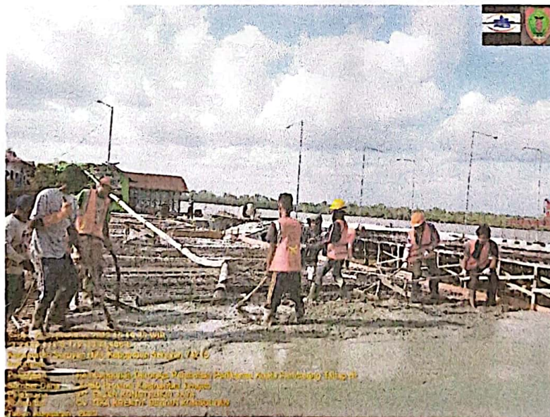
PEKERJAAN PENGECORAN BALOK, BALOK FENDER & LANTAI DERMAGA
