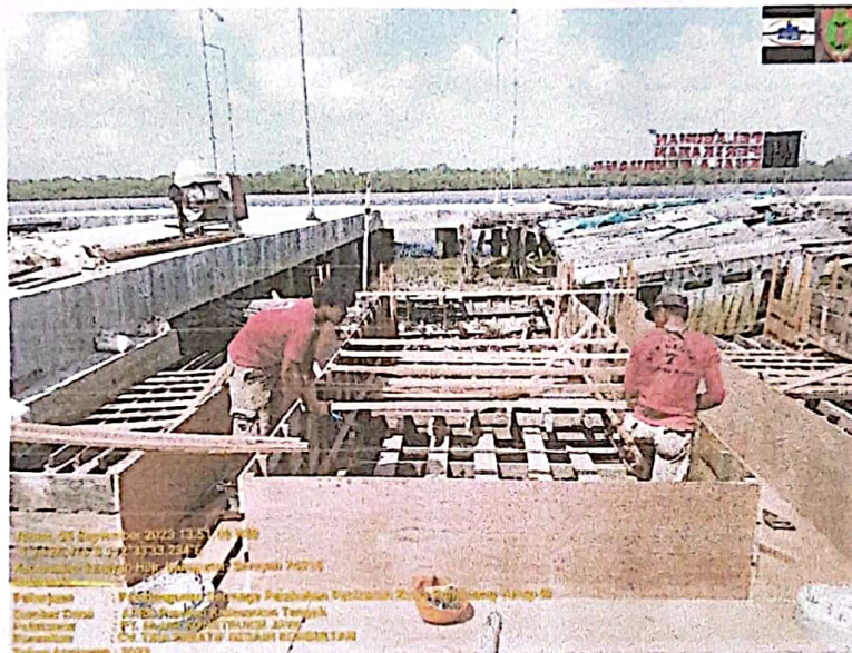
PEKERJAAN BEKISTING BALOK
