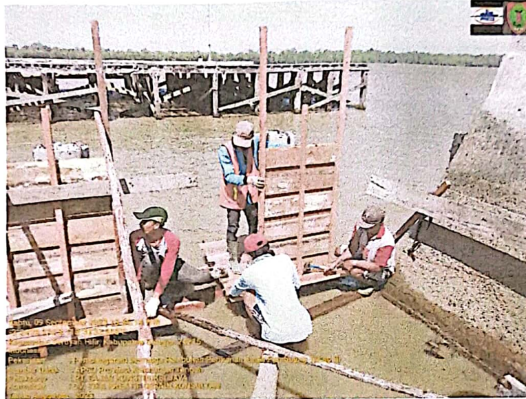
PEKERJAAN BEKISTING BALOK FENDER
