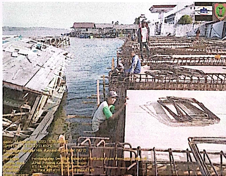
PEKERJAAN PERAKITAN PEMBESIAN FENDER
