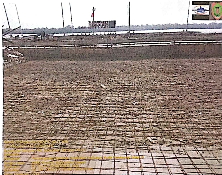
PEKERJAAN PERAKITAN PEMBESIAN DIREKSI KEET LAMA
